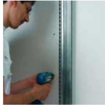
Fase 2 Fissaggio pannelli Phase 2 Panel board fixings
