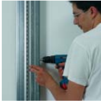
Fase 1 Fissaggio profili Phase 1 Outline fixings
