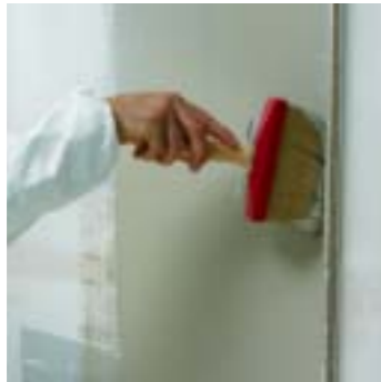
Fase 4 Tinteggiatura con protezione profilo Phase 4 Painting with outline protection
